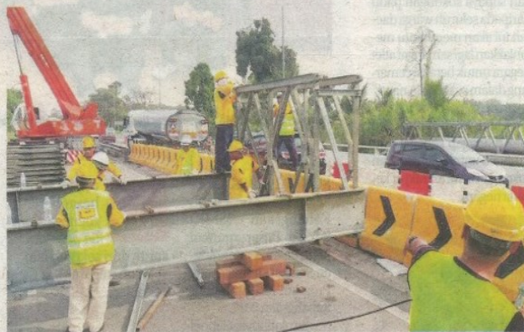
Keja-kerja pembaikan di dua buah jambatan di Sungai Rambai giat dijalankan.
